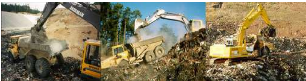
Slika 14 - Iskopavanje stabilizovanog tela deponije
