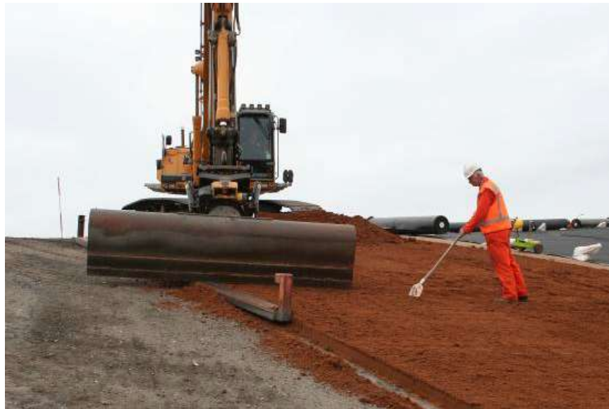
Slika 18 - Razastiranje Trisoplasta i provera debljine sloja pre sabijanja
